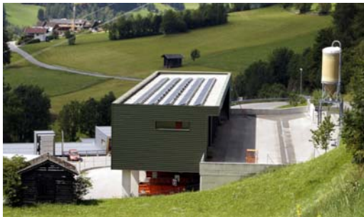
Beispiel Solaranlage RCH Virgen
